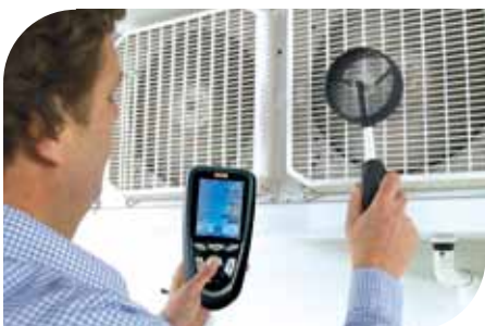
空调系统检测
